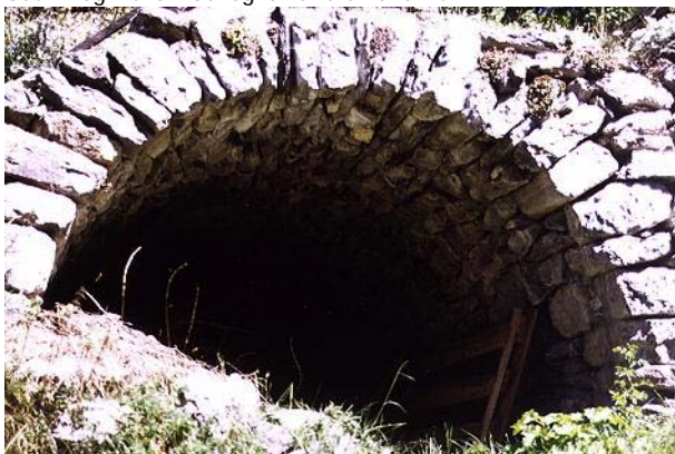
Abbildung 3-4 Trockengemauertes Gewölbe bei Sambucco, Piemont
