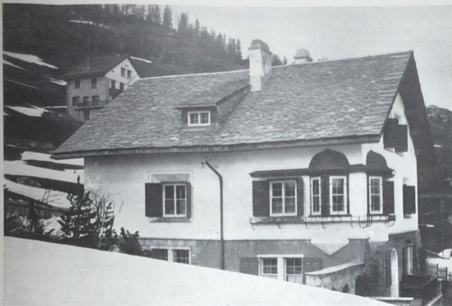
Ein unregelmässiges Plattendach neuerer Zeit.
