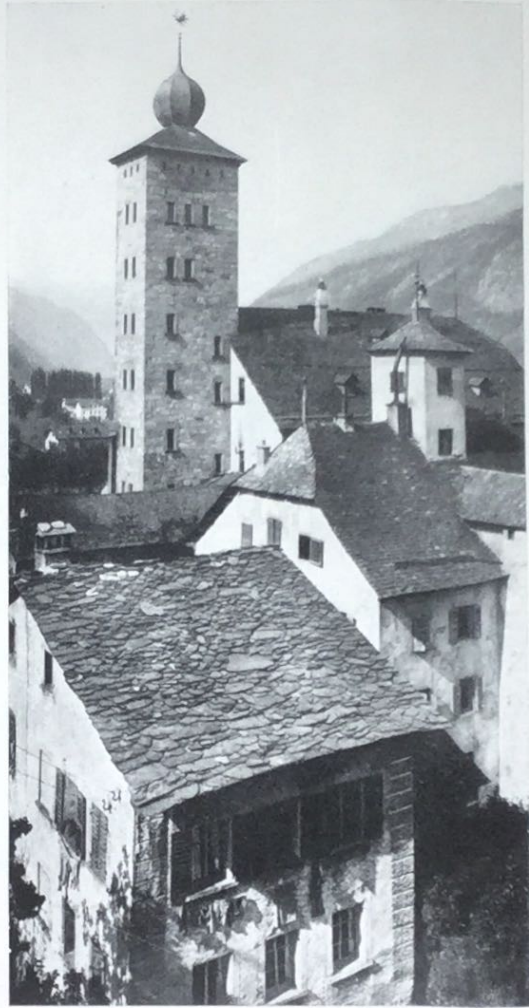
Ein altes Plattendach im Wallis mit ganz unregelmässigen Schieferplatten.
